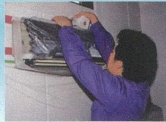
養生マスキングテープをエアコン本体周囲に巻く。
