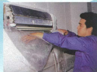
養生マスキングテープをホッパー内に片付ける。
