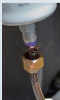
冷媒漏えいの大きな要因にフレア部からの漏えいがあります。
